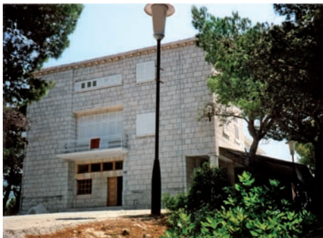
Zgrada vinarije „Grgić vina”, Trstenik, 1997
